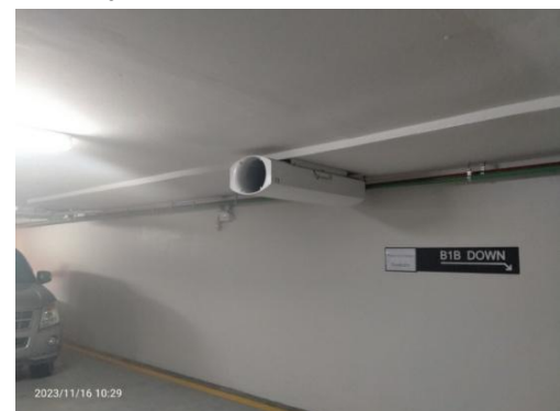
รูปที่ 2-11 พัดลมอัดอากาศชั้นลานจอดรถ
