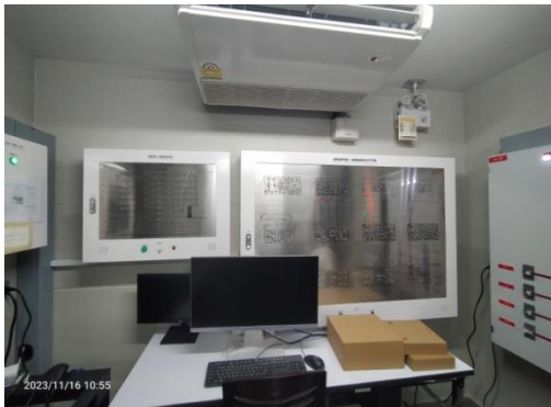
รูปที่ 2-28 แผงควบคุม (FCP)
